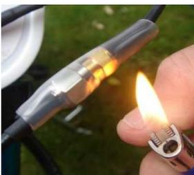
ATTENTION : Il est très important de mettre une gaine thermo-rétractable à chaque raccord antenne/câble.
